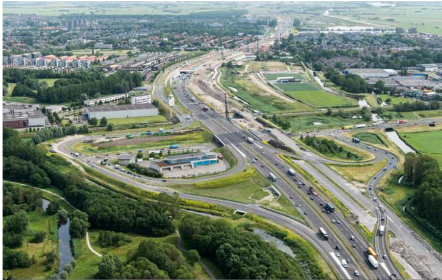
1.24 - Het knooppunt van de A4 met de N11 en de Willem van der Madeweg te ter hoogte van Leiden en Zoeterwoude-Rijndijk. In de linkerhoek is de groene omlijsting van het Polderpark Cronesteyn zichtbaar. Datering onbekend, vermoedelijk 2012 (© Rijkswaterstaat, Foto: Joop van Houdt Luchtfotografie).
