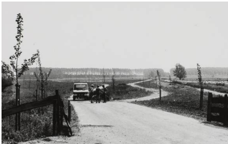
2.9 - Polderpark Cronesteyn tijdens de aanleg in 1983. De bomen vormen dunne sprietjes in het verder zeer kale landschap (ELO, PV29329L.6. Fotograaf J.W.C. Postel).
